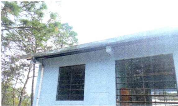
Foto 3: Canales de lámina galvanizada instalados
