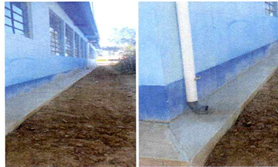
Foto 4: Banqueta de protección en aulas mejoradas
