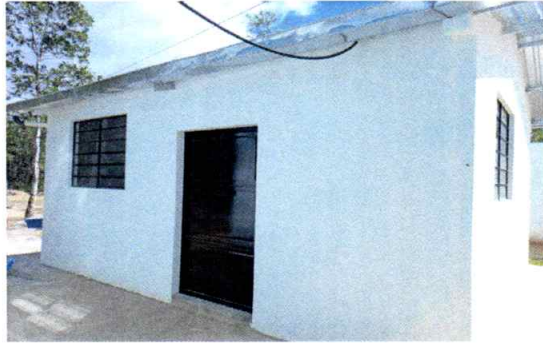
Foto1: Terminación del mejoramiento a cocina en cubierta de lámina, estructura de soporte, puertas, ventanas, piso, sistema eléctrico, estufa rural, mueble de concreto y lavatrastos
